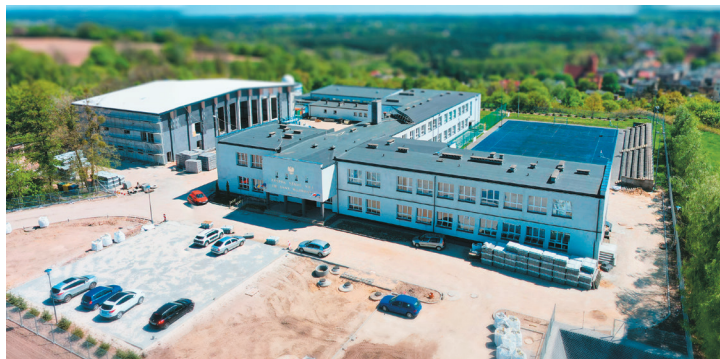
Budowa hali sportowej przy Zespole Szkół nr 1 w Golubiu-Dobrzyniu
